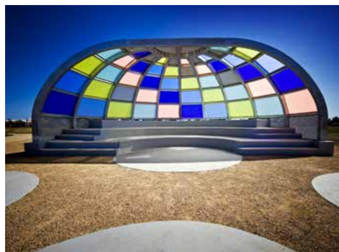
Amphithéâtre d'une école, Australie | ©Photo: Pavan Consultants / Mitchell Plastics
