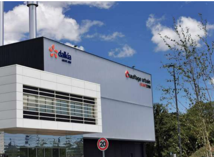
Chaufferie Surville - AkyVer Paneltherm Anti éblouissement
